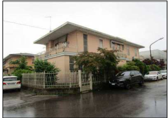
Vista esterna da nord-est
