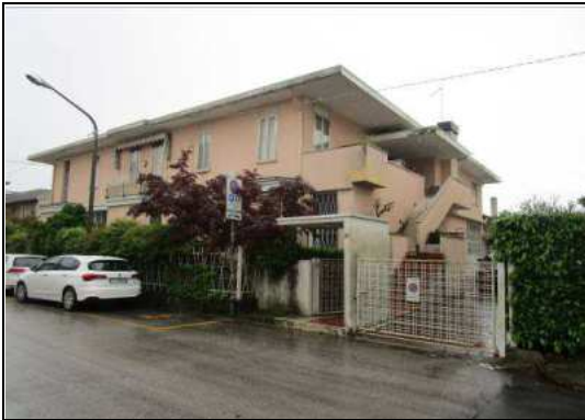
Vista esterna da nord-ovest
