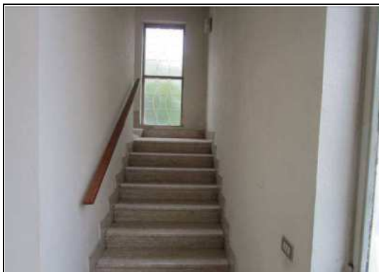
Vano scala ingresso
